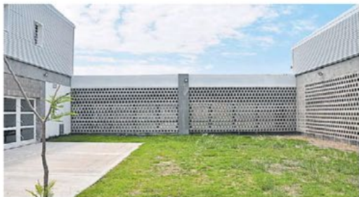
MUROS PERFORADOS. Permiten el paso de luz natural y ventilación.
